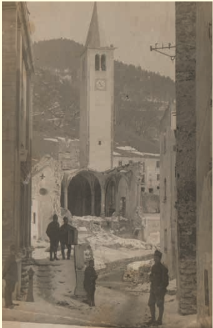
Abb. 4: Siebenundvierziger im zerstörten Castel Tesino Anfang 1918
